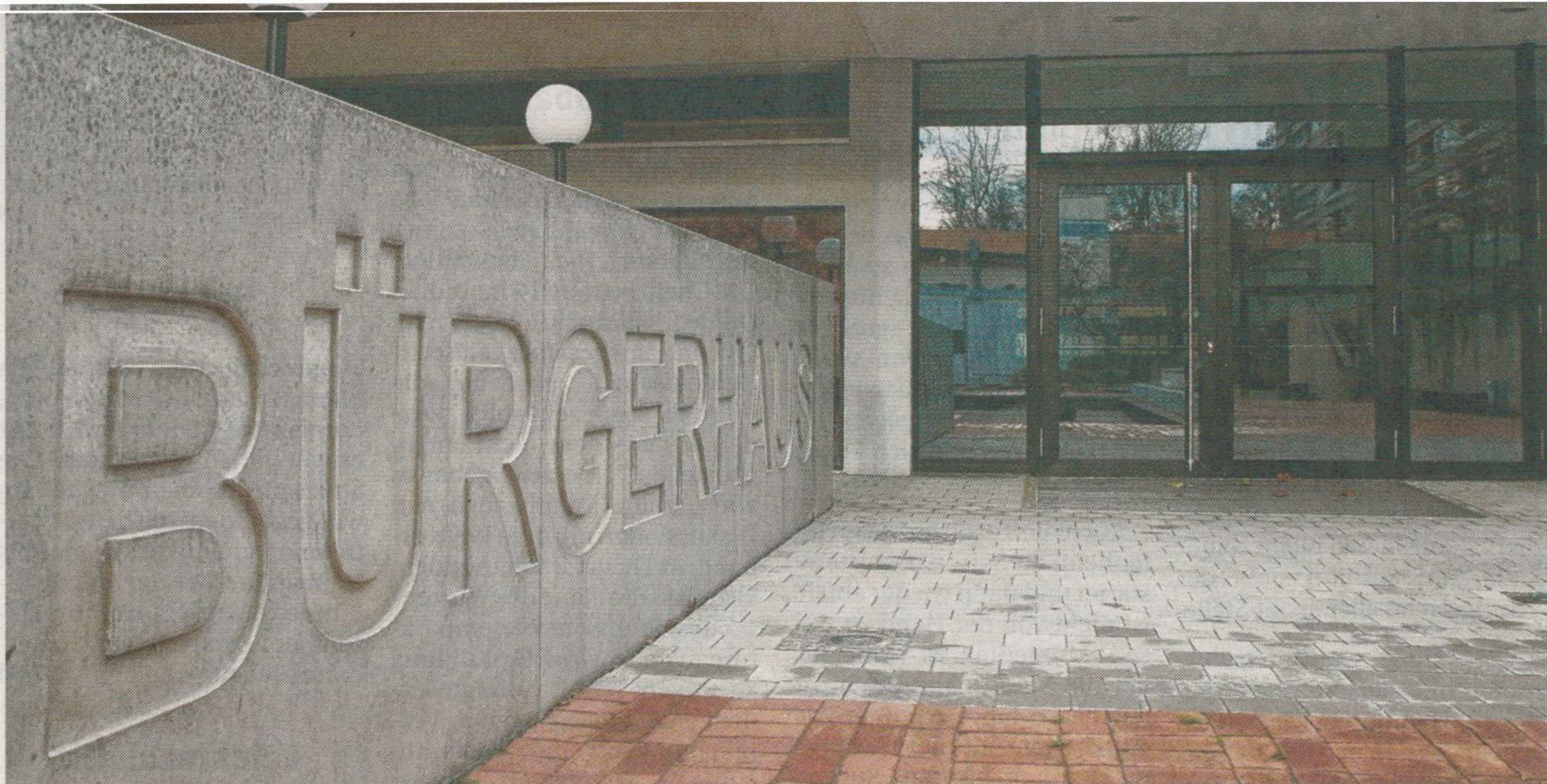
Das Bürgerhaus wird gerade umgestaltet.
